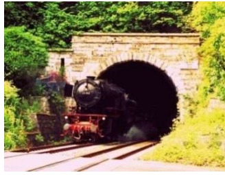
Schlossbergviadukt Ost Portal
