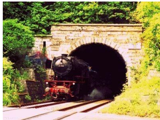
Schlossbergviadukt Ost Portal
